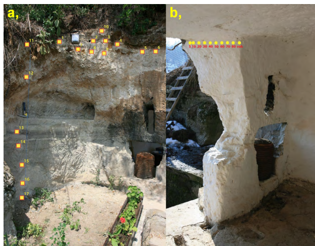
Obr. 12. Lokalizácia meraných bodov povrchovej teploty a vlhkosti: a) profil 1 – vonkajšia, čelná strana masívu; b) profil 2 – vstupný portál do skalného obydlia (foto: Brček, 2012).
