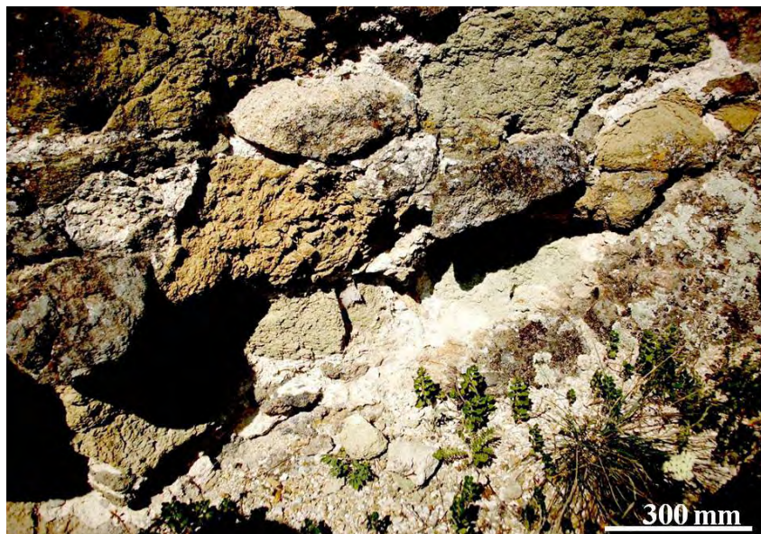
Fig. 4. Building stone of different alteration levels in the lower part of the wall: from color change to total disintegration, wall overhangs. Obr. 4. Stavebný kameň v rôznom stupni alterácie v dolnej časti múrov: od zmeny farby až po úplný rozpad, previsy.
